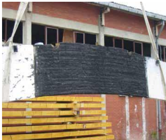
Slika 7. Demontaža izgorenog lameliranog nosača http://drvene-konstrukcije.hr/karakteristike-lll/
