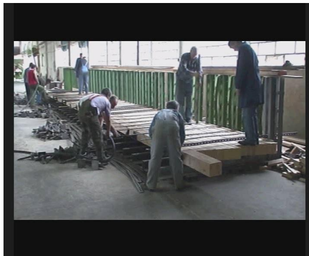
Slika 15. Postolje za pritezanje lamela http://drvene-konstrukcije.hr/karakteristike-ld/
