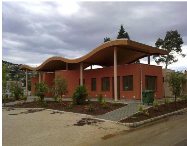
Slika 4. Turistički objekt u Rabcu - konstrukcija u obliku vala http://drvene-konstrukcije.hr/karakteristike-lld/
