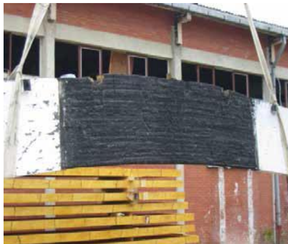
Slika 7. Demontaža izgorenog lameliranog nosača http://drvene-konstrukcije.hr/karakteristike-lld/
