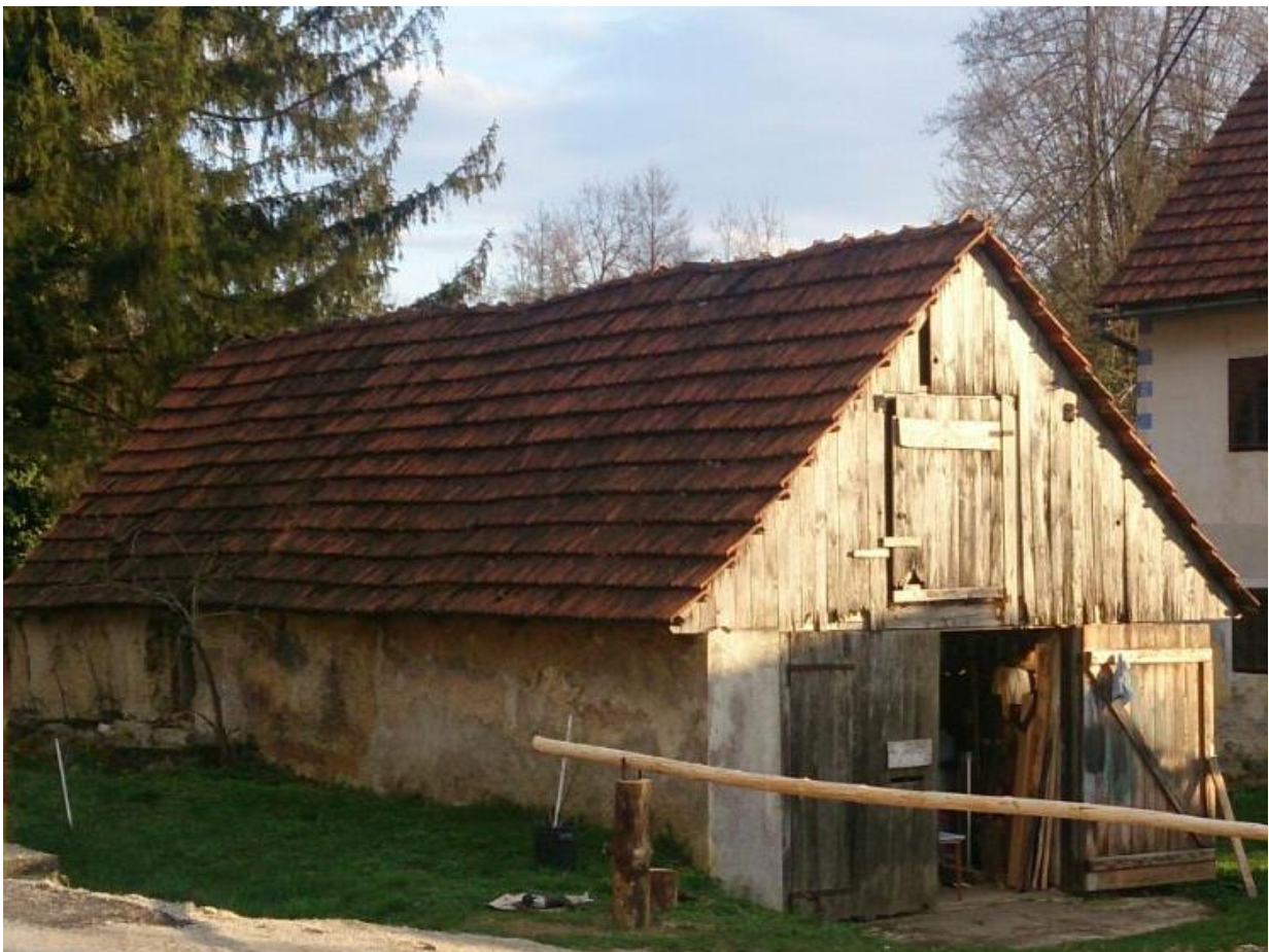
Slika 65. Gospodarska zgrada u postojećem stanju (Fotografija: Klanfar, F.)
