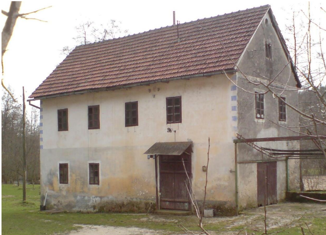
Slika 23. Glavna zgrada u postojećem stanju
