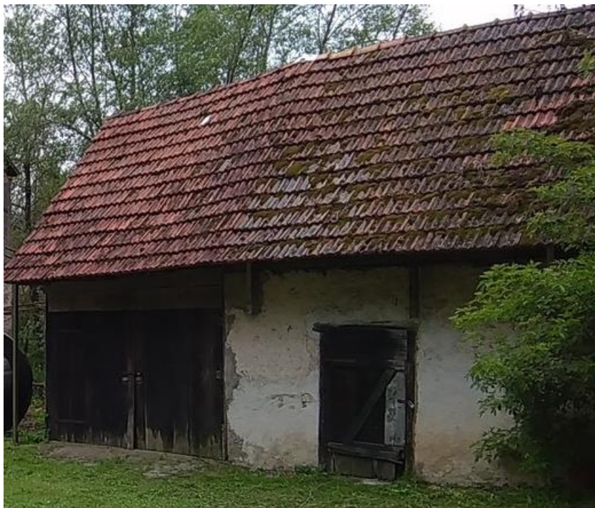
Slika 73. Kovačnica u postojećem stanju (Fotografija: Klanfar, F.)
