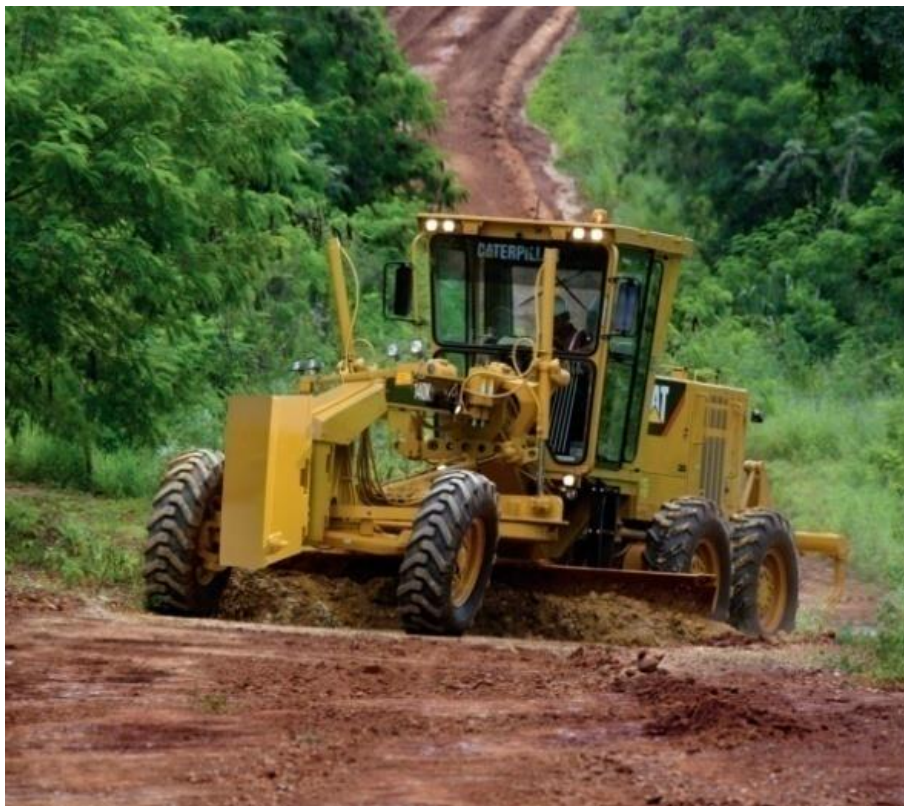
Slika 13. Održavanje ceste primjenom grejdera
