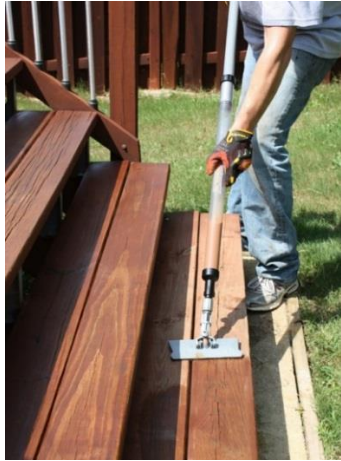
Slika 6 Nanošenje lazure
