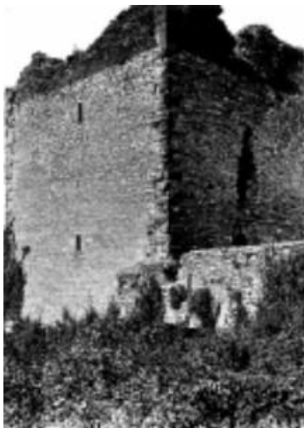
Slika 2. Stari grad ( burg ) Medvedgrad i prozori na prvom i trećem katu (Horvat 1997.)
