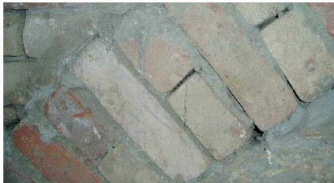
Slika 10 Zidovi od opeke Izvor: Lončar-Vicković i Stober, 2011
