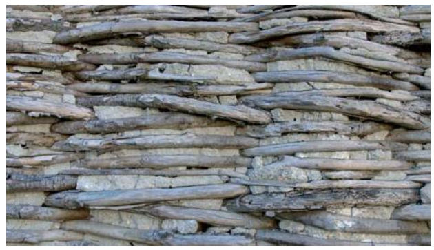
Slika 9 Zidovi od pletera Izvor: Lončar-Vicković i Stober, 2011
