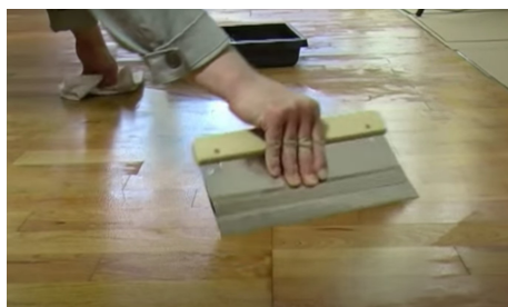
Slika 7. Nanošenje ulja lopaticom
