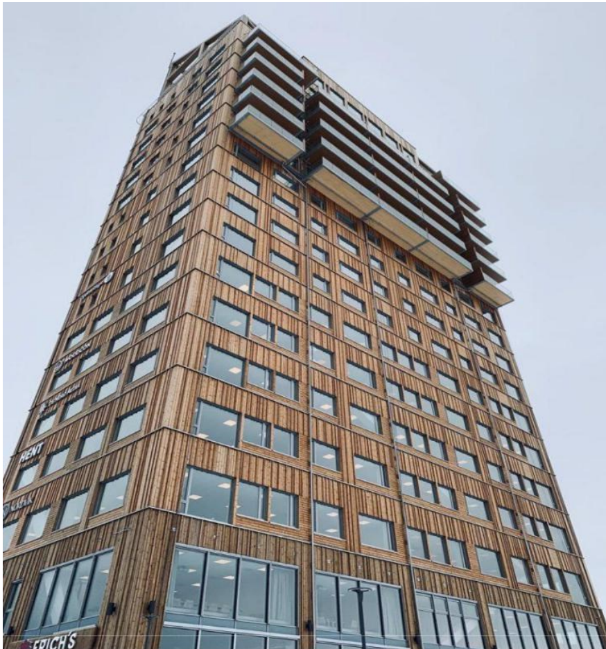
Slika 11. Najviša drvena građevina na svijetu u Norveškoj, toranj Mjøstårnet ( web 6)
