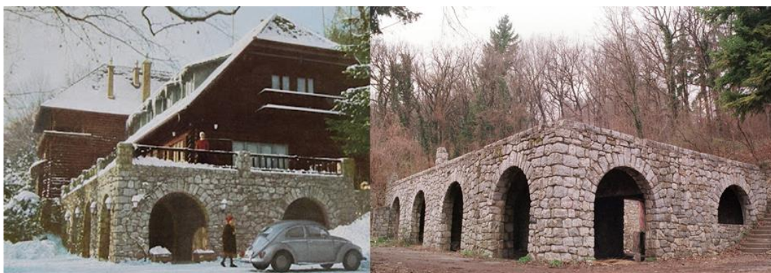
Slika 70. Fotografije Vile Rebar prije i poslije požara (Izvor: http://www.medvednica.info/2010/10/villa-rebar.html Pristupljeno: 21.8.2021.
