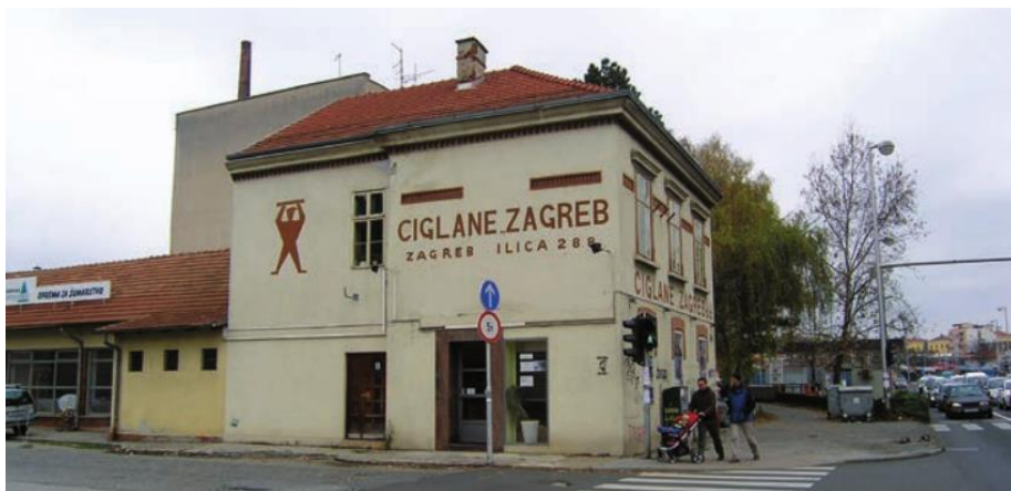
Slika 76: Upravna zgrada ciglane (Izvor: http://www.casopis-gradjevinar.hr/assets/Uploads/JCE-67-2015-11-8-Ind-bastina.pdf Pristupljeno: 15.7.2021.)
