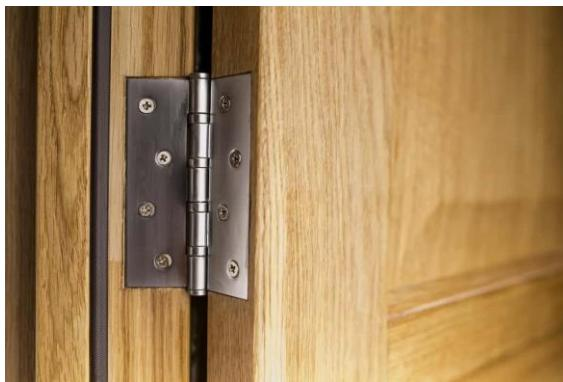
Slika 8.4 Ugrađena zglovnica između vrata i dovratnika
