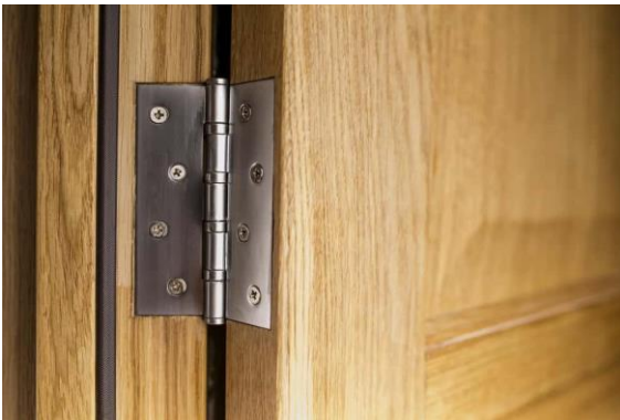
Slika 8.4 Ugrađena zglobnica između vrata i dovratnika
