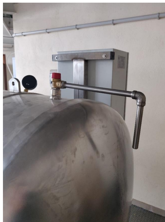
Slika 10: Sigurnosni ventil (fotografija: Kvakan, 2022.)
