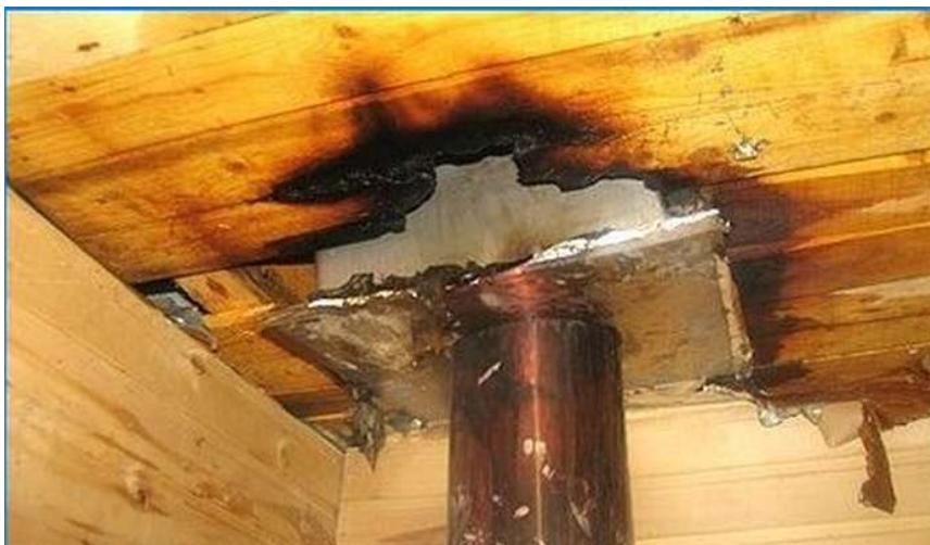
Slika 5. Prikaz pougljenog sloja drva nastao pri požaru
