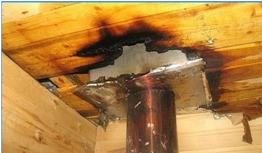
Slika 5. Prikaz pougljenog sloja drva nastao pri požaru
