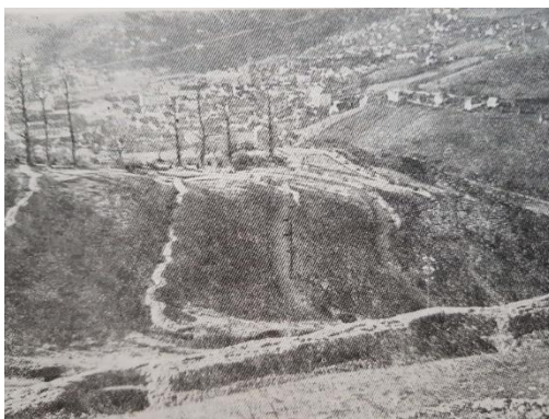
Slika 6. Infiltracijske bankete alžirskog tipa (Izvor: Lujčić 1973)
