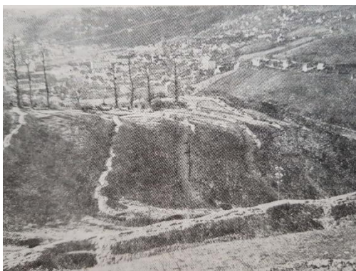
Slika 6. Infiltracijske bankete alžirskog tipa (Izvor: Lujčić 1973)
