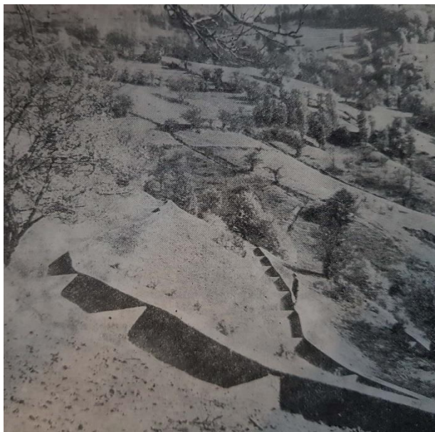
Slika 11. Detalj standardnog rova američkog tipa (Izvor: Lujčić 1973)
