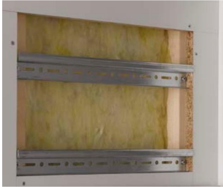
Slika 17. Mineralna vuna u prostoru zračnog jastuka (Egger acoustic katalog, 2016)
