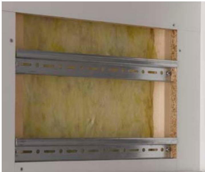
**Slika 17.** Mineralna vuna u prostoru zračnog jastuka (Egger acoustic katalog, 2016)
