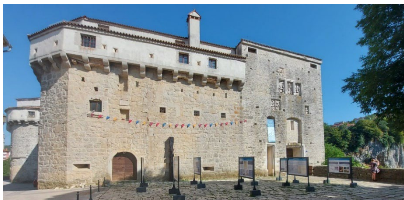
Slika 34. Pazinski „Kaštel“ gdje su smješteni muzeji (Fotografija: Lukež, 2023).
