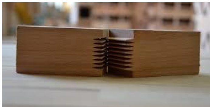
Slika 19. Dužinsko spajanje klinastim zupcima
