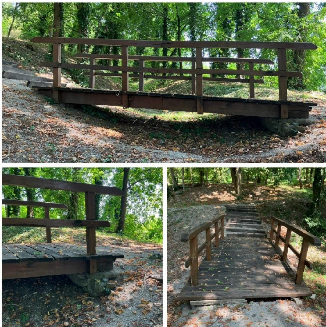
Slika 11. Izgled drvenog mosta
