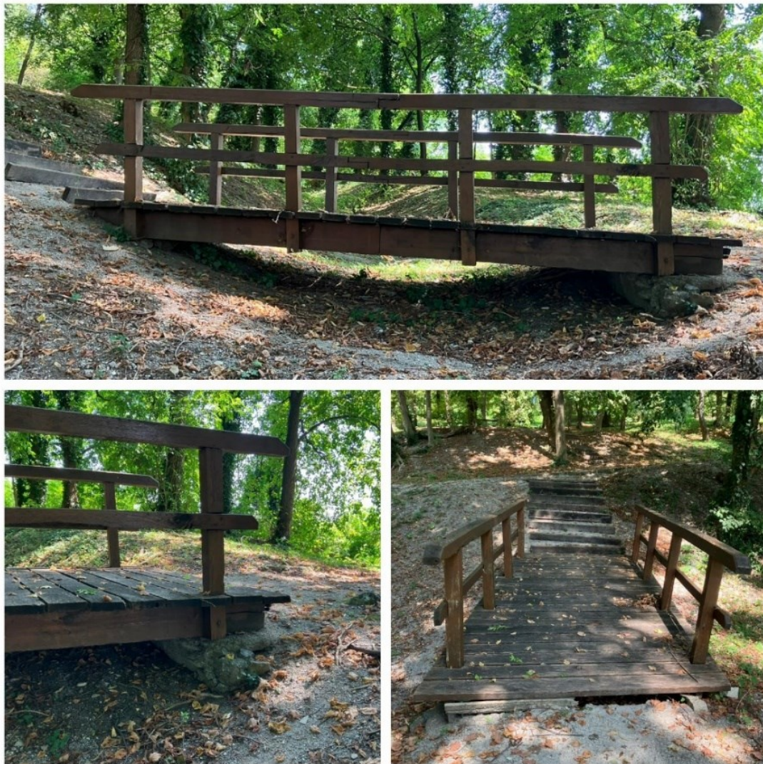
Slika 11. Izgled drvenog mosta
