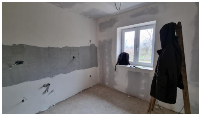
Slika 7. Nedovršeni prostor 1 na lokaciji 1
