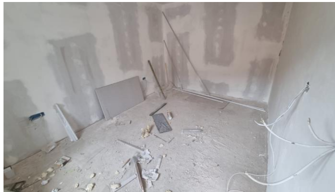
Slika 9. Nedovršeni prostor 3 na lokaciji 1
