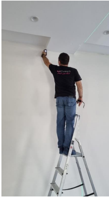
Slika 18. Izmjera prostora 2 na lokaciji 4
