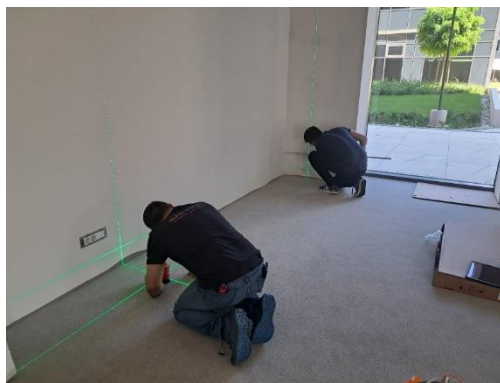
Slika 17. Izmjera prostora 1 na lokaciji 4
