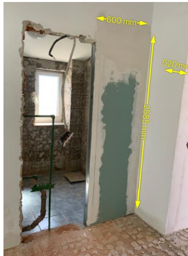
Slika 14. Nedovršeni prostor 1 na lokaciji 3
