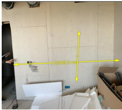
Slika 11. Nedovršeni prostor 2 na lokaciji 2
