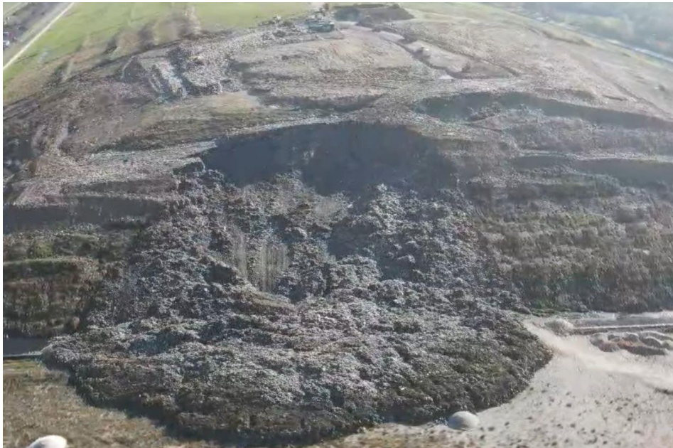
Slika 12. Izgled odlagališta Prudinec - Jakuševac nakon prvog odrona 2023. godine (Izvor: https://www.zagreb.info/vijesti/golemi-odron-smeca-na-jakusevcu-zagrepcani-se-zale-na-smrad-ostvemu-se-oglasili-iz-grada/567563/ )
