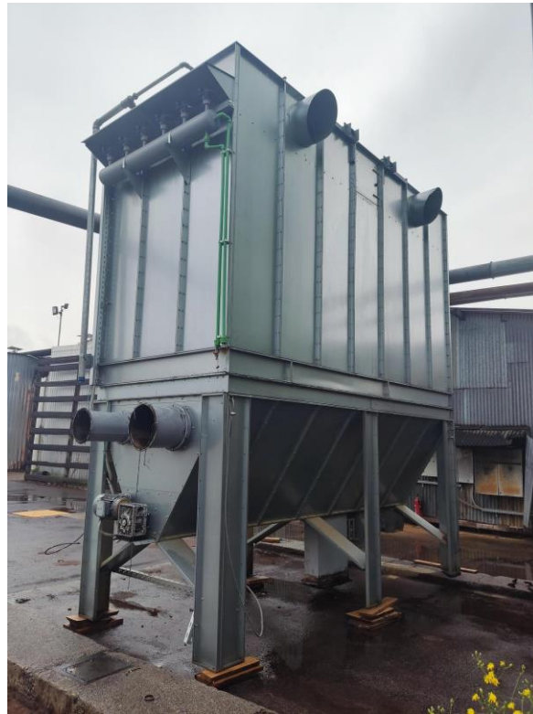
Slika 9. Filtarski odvajač čestica
