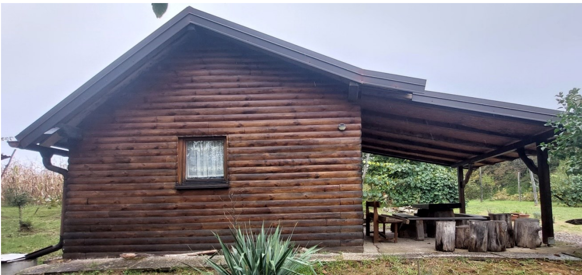
Slika 8. Snimka - J pročelje. Pročelje je adekvatno zaštićeno širokom strehom.
