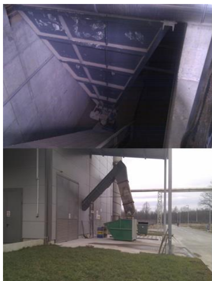
Slika 12. Otpadni sustav energane gdje odlazi neiskorišteni pepeo
