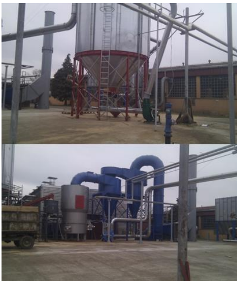
Slika 19. Silos za piljevinu i postrojenje za brikete
