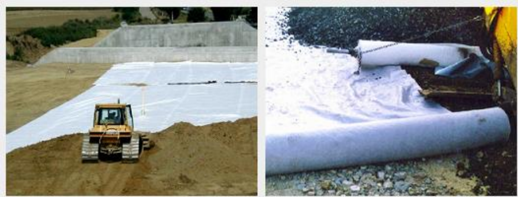
Slika 10. Netkani geotekstil i njegovo postavljanje na terenu (izvor: Geotekstili, 2016)
