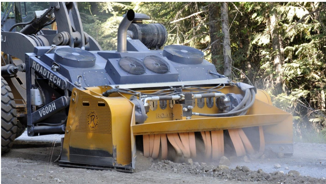
Slika 4. Metoda popravka kolnika drobljenjem kamenog materijala
