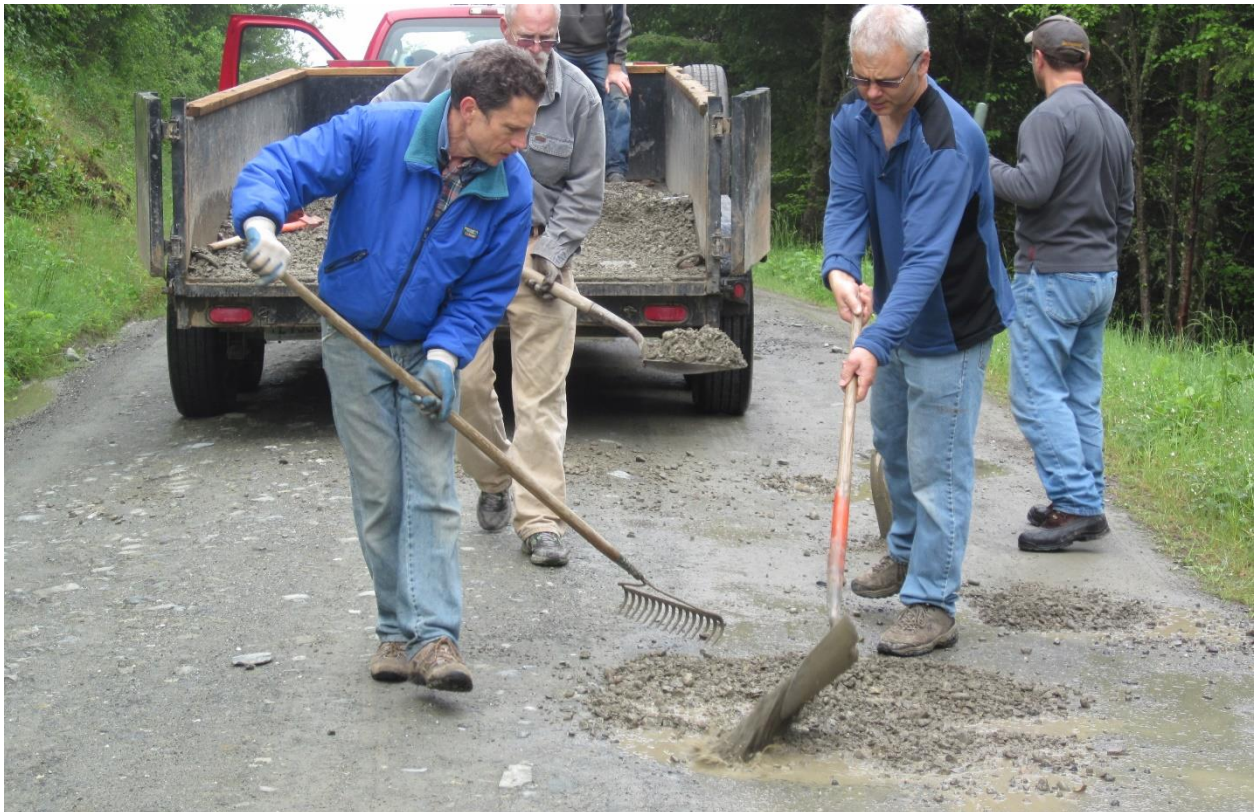
Slika 1. Metoda popravka kolnika krpanjem
