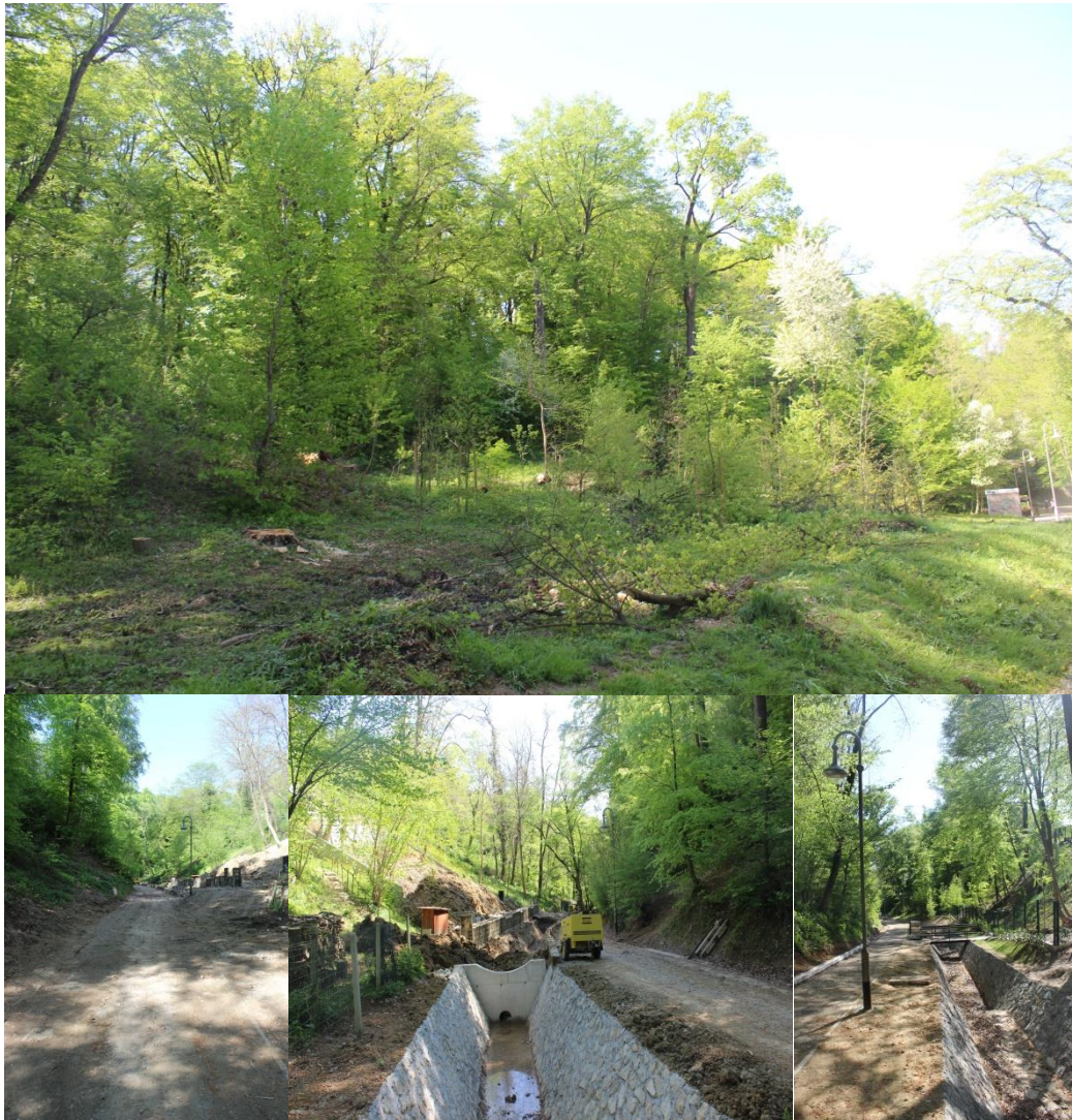
Slika 38. Radovi na kanaliziranju potoka, uređenje same trase šetnice te okolnog terena u suradnji Hrvatskih šuma i Hrvatskih voda (foto: Tikvić, 2016.)
