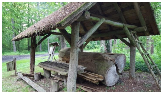
Slika 48. a) šumarska kuća sa sjenicom smještena duboko u unutrašnjosti GJ Varoški lug s prednje strane, b) šumarska kuća i sjenica sa stražnje strane, c) natkriveno deblo staroga hrasta lužnjaka izloženog kao skulptura
