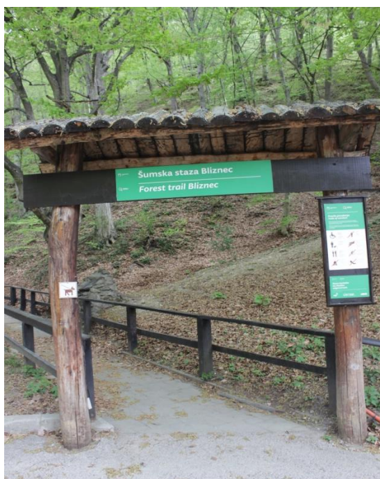
Slika 22. Ulazni portal na početku poučne šumske staze Bliznec (foto: Tikvić, 2016.)
