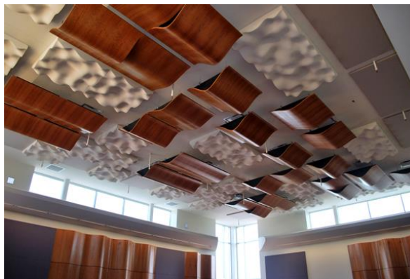
Slika 17 Drveni elementi u obliku difuzora (Total Vibration Solutions)
