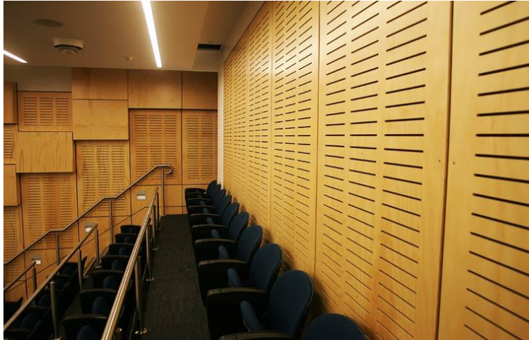
Slika 21 Primjer postavljenih perforiranih ploča u dvorani (Alibaba.com)
