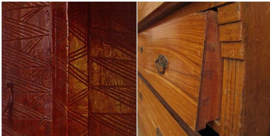
Slika 47. Inspiracijski elementi – škrinja i spoj „lastin rep“
