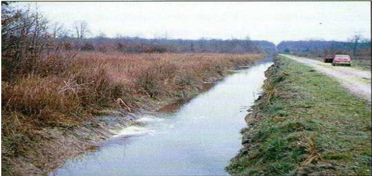
Slika 6. Prikaz preintenzivne kanalske odvodnje
