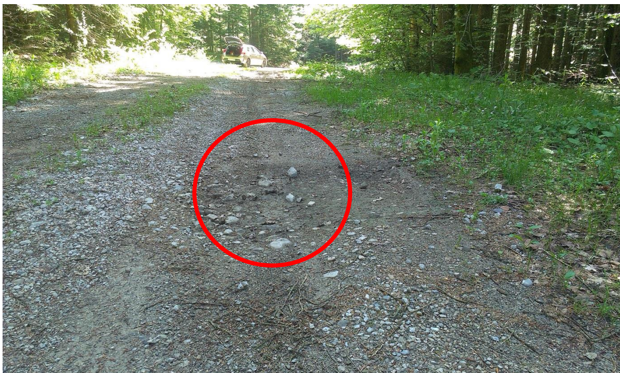
Slika 108. Udarana rupa na poligonu za mjerenje vibracija
