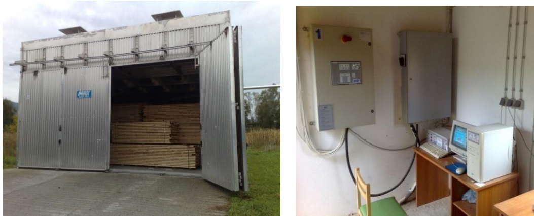
Slika 11. Sušionica i upravljačka jedinica http://drvene-konstrukcije.hr/karakteristike-lld/
