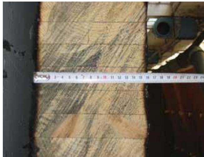
**Slika 8.** Lamelirani nosač izgubio 4 cm nakon požara
