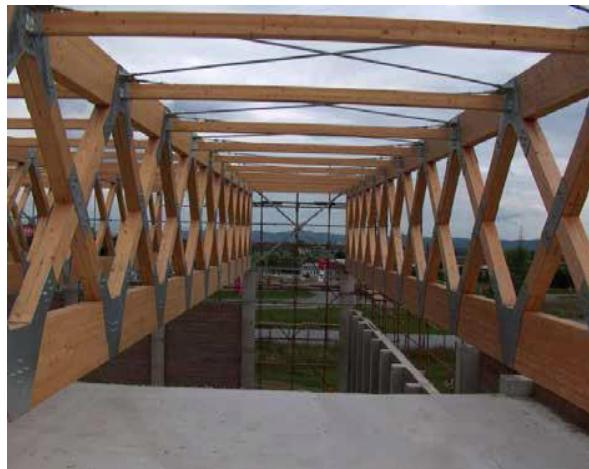
**Slika 2.** Rešetkasti nosači od LLD-a. Raspon konstrukcije 36,50 m
