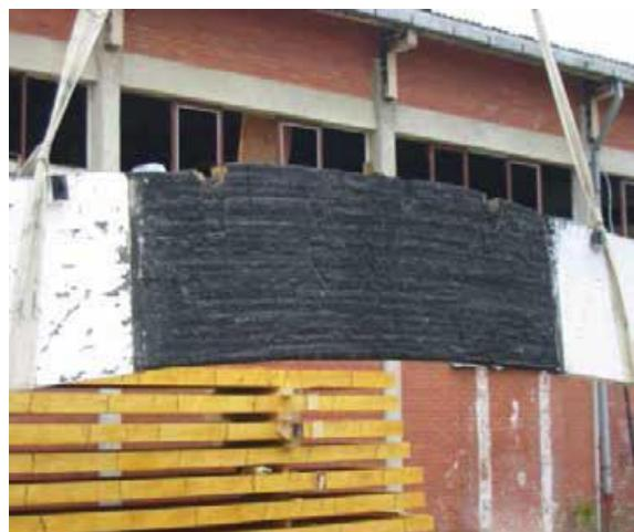
**Slika 7.** Demontaža izgorenog lameliranog nosača
