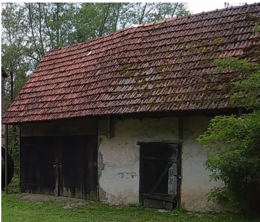
Slika 73. Kovačnica u postojećem stanju (Fotografija: Klanfar, F.)
