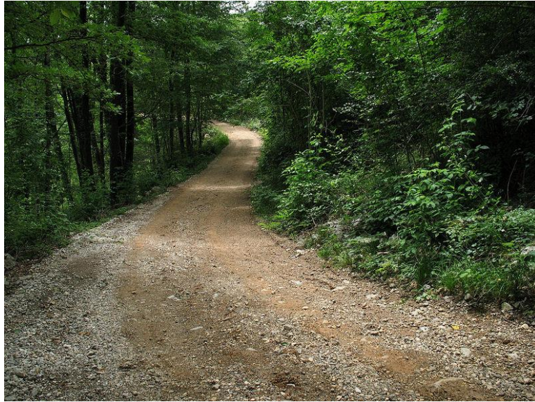
Slika 5. Protupožarna prosjeka s elementima šumske ceste
