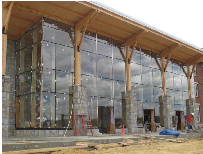
Slika 47: Primjer staklene fasade na drvenoj konstrukciji ( www.eurostarfen.com )
