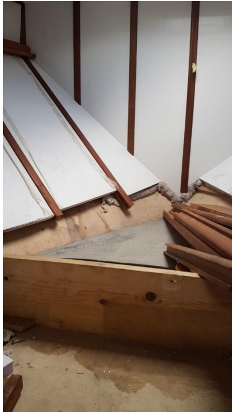
Slika 20. Postavljanje plastičnih panela Izvor: Pećarina, 2019.
