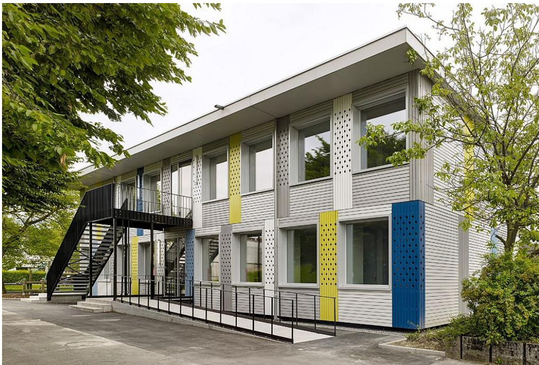
Slika 25. Gotov objekt, Lehmann Izvor: Web 3
