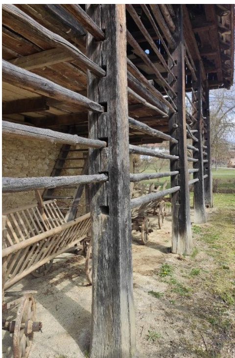
Slika 35 Detalj istaka nadstrešnice, Kumrovec
