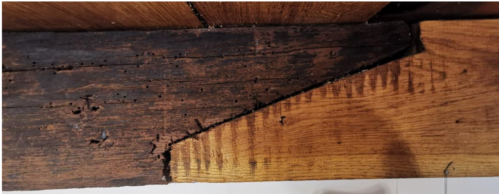
Slika 7. Dužinsko sastavljanje greda Izvor: Lozančić i sur., 2020
