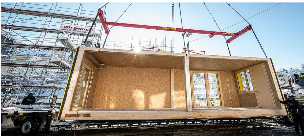
Slika 24. Konstrukcija jednog modula, Lehmann Izvor: Web 3
