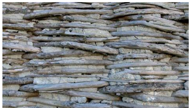
Slika 9 Zidovi od pletera Izvor: Lončar-Vicković i Stober, 2011
