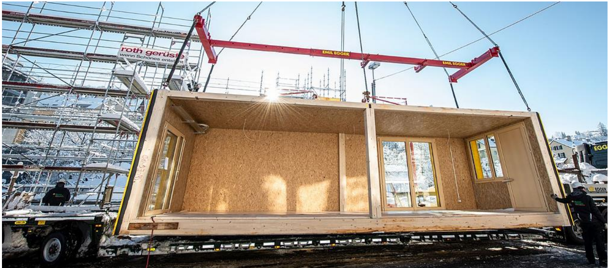
Slika 24. Konstrukcija jednog modula, Lehmann Izvor: Web 3
