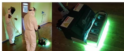
**Slika 11.** Mobilni uređaj za otvrdnjavanje UV premaza
