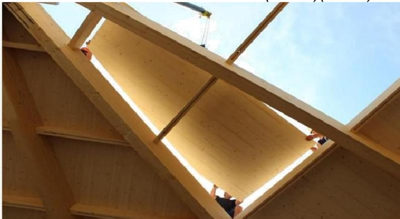
*Slika 13. Krovni sklop s CLT pločama na lijepljenoj lameliranoj primarnoj konstrukciji drva. (Schilliger Holz AG, 2012.)*
