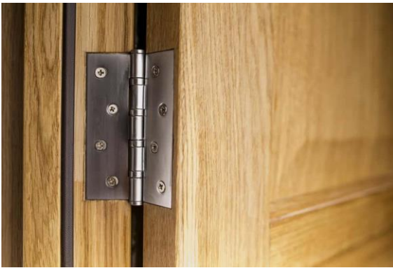
Slika 8.4 Ugrađena zglobnica između vrata i dovratnika
