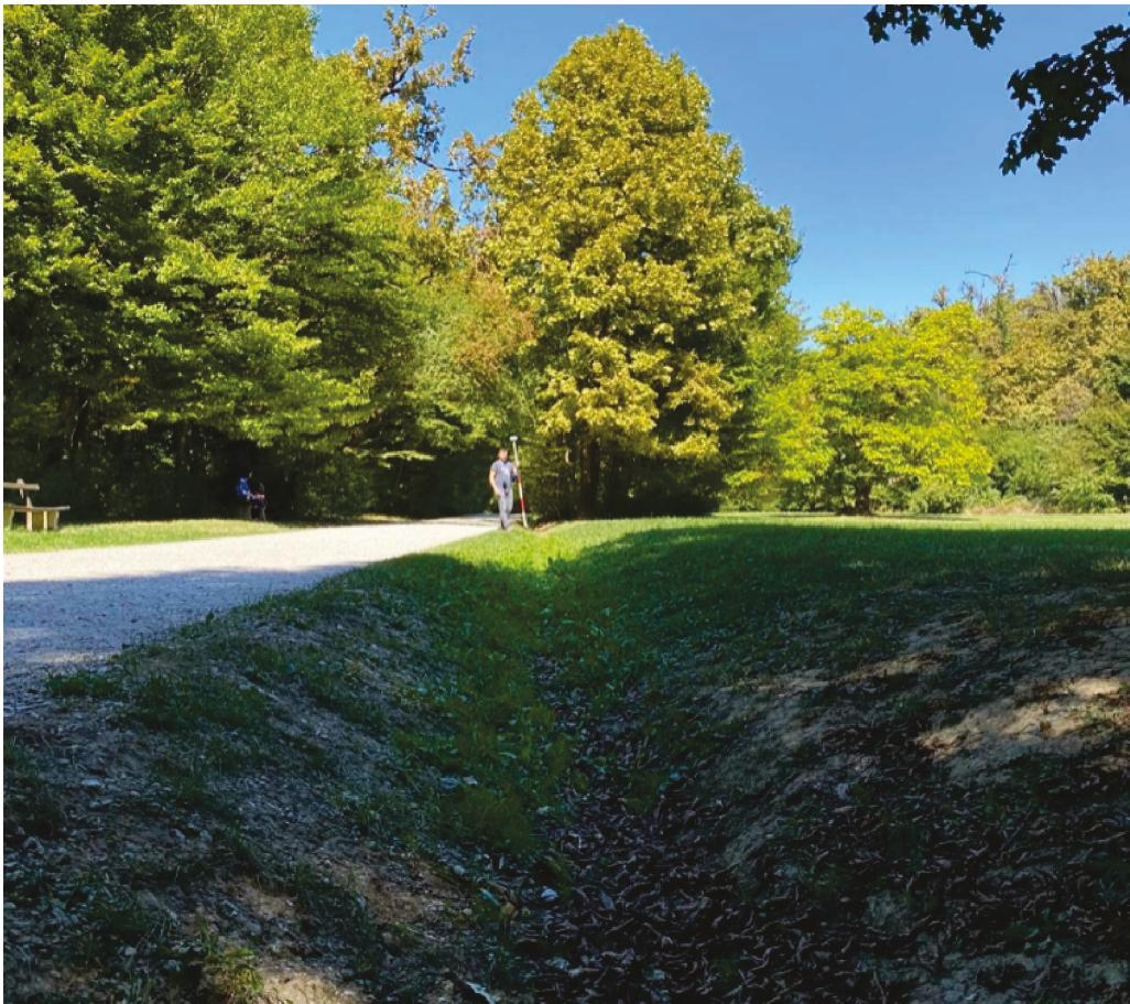
*Slika 35. Odvodni jarak uz livadu orema 4. jezeru*
