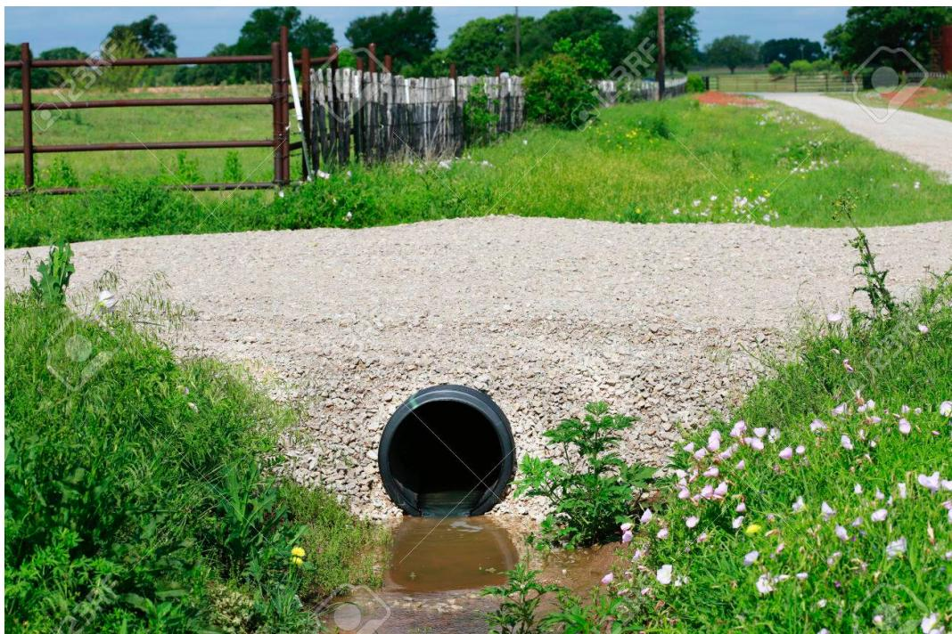
Slika 24. Primjer cijevnog propusta zatvorenog tipa (Izvor:www.shutterstock.com)
