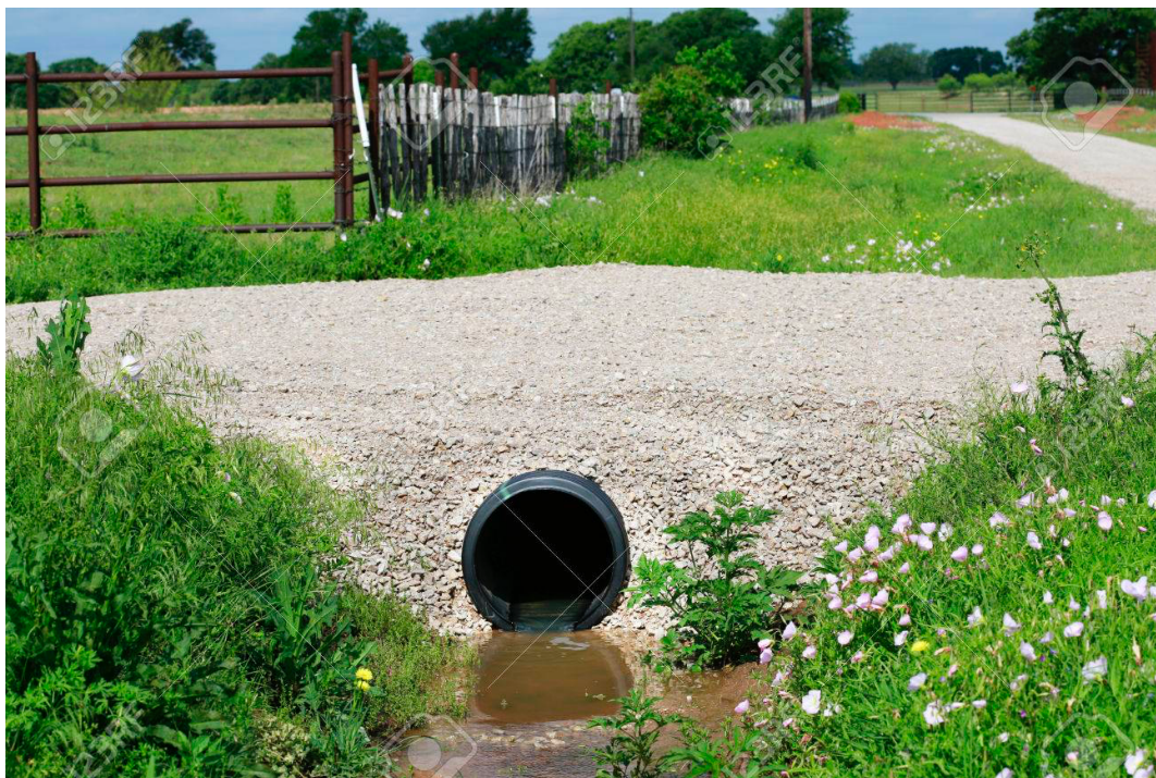
Slika 24. Primjer cijevnog propusta zatvorenog tipa (Izvor:www.shutterstock.com)
