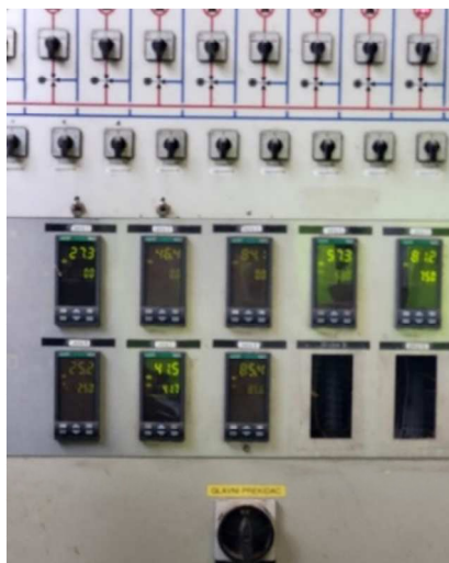
Slika 7. Temperaturna mjerenja trupaca u fazama kuhanja (foto: Ivanda, A., 2022.)
