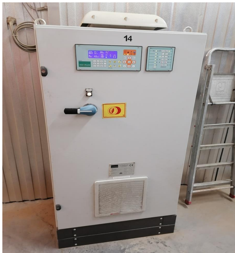
Slika 28. Automatika sušionice
