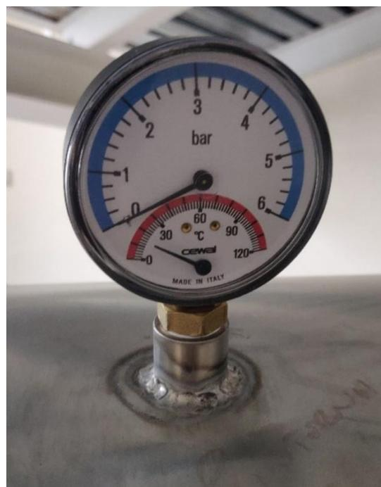
**Slika 6:** Termometar/barometar ugrađen u kotao
