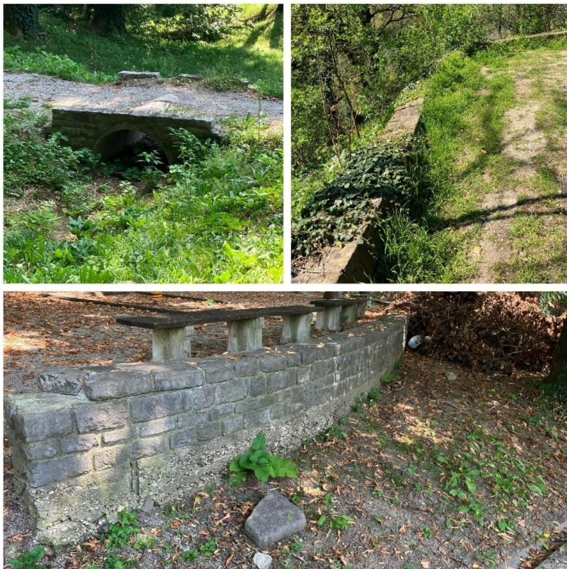
Slika 9. Izgled kamenog zida
