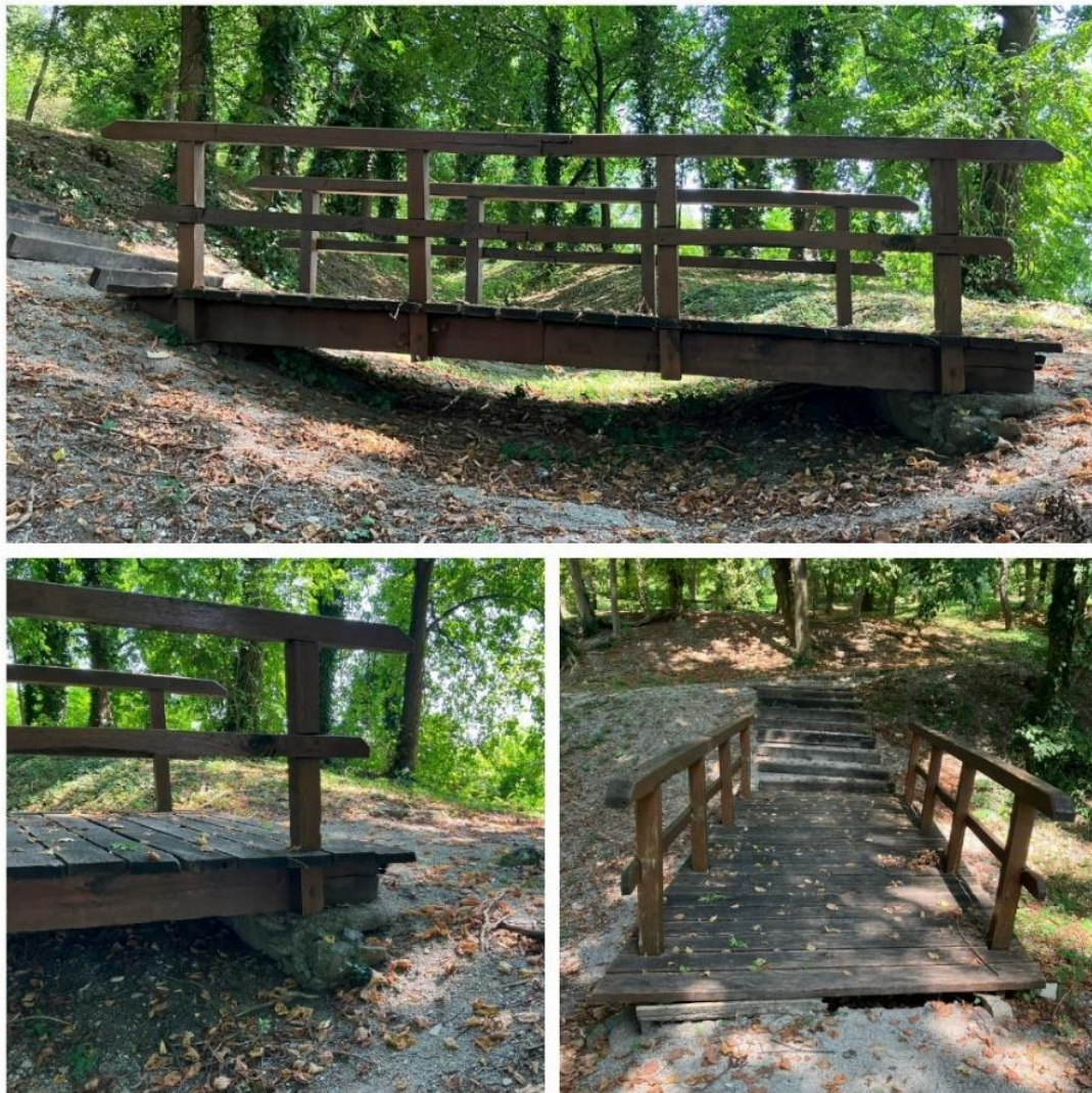
Slika 11. Izgled drvenog mosta
