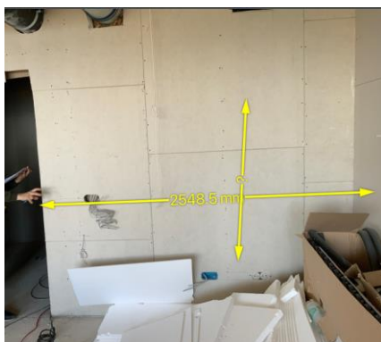
Slika 11. Nedovršeni prostor 2 na lokaciji 2
