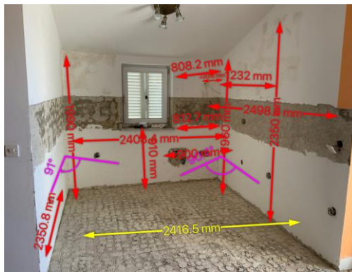
Slika 16 Nedovršeni prostor 3 na lokaciji 3
