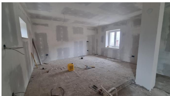
Slika 8. Nedovršeni prostor 2 na lokaciji 1
