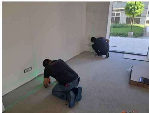
Slika 17. Izmjera prostora 1 na lokaciji 4
