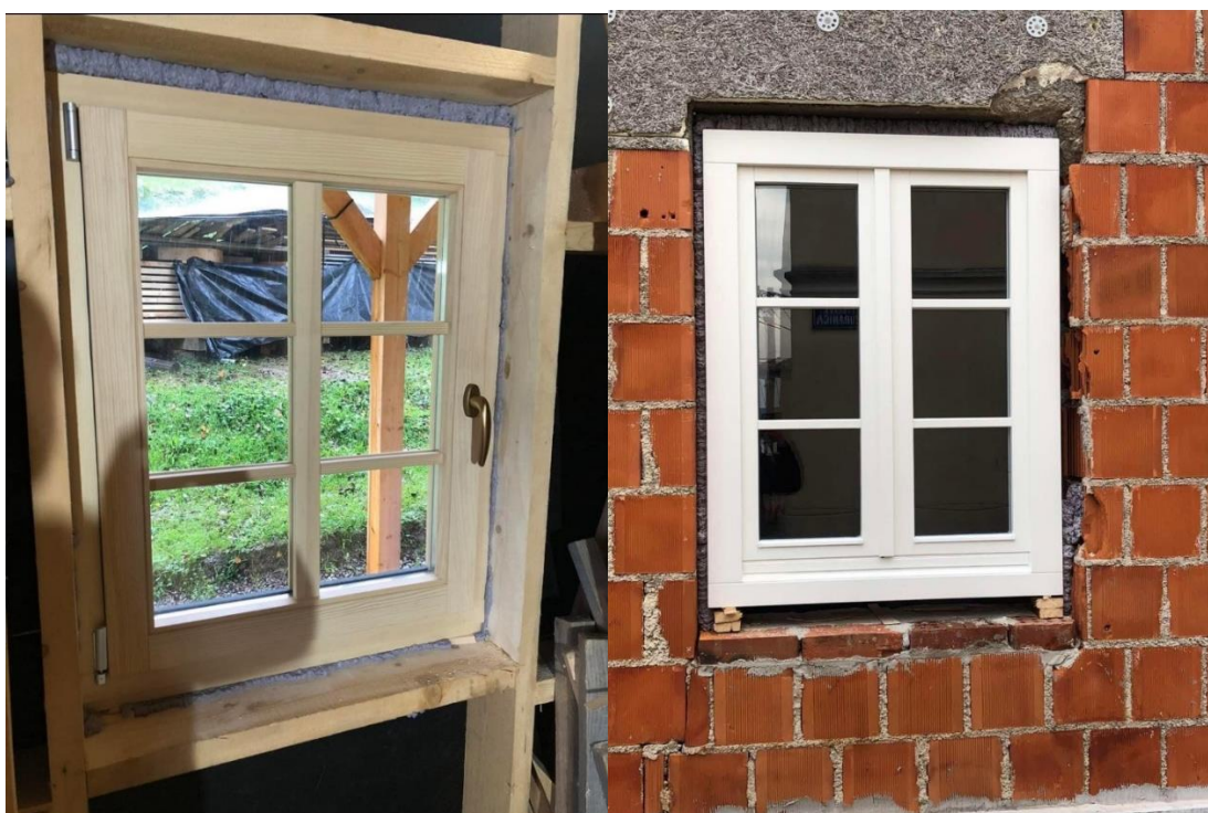
Slika 22 i 23: Prozor na objektu
