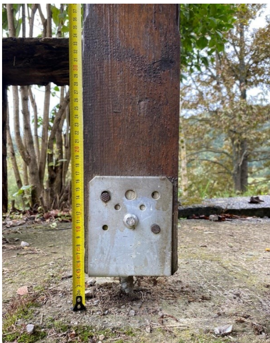
Slika 13. Snimka – detalj spoja stupa i temeljne ploče
