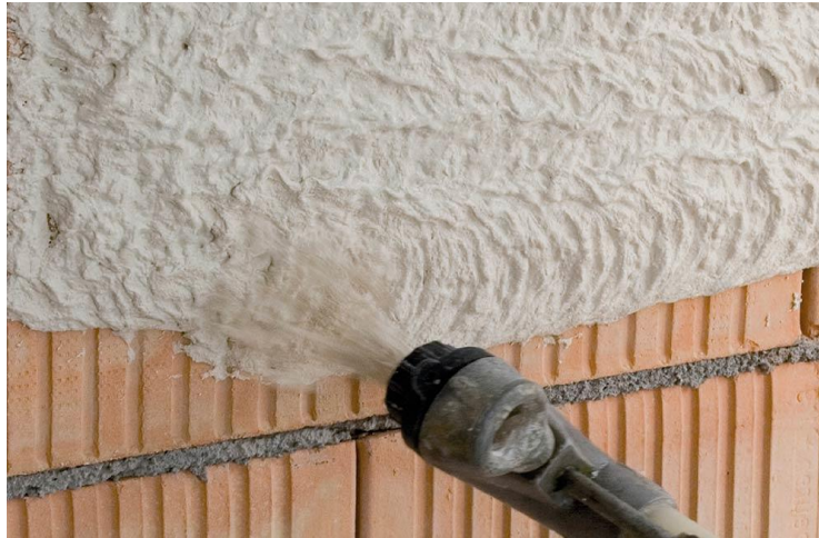
Slika 9. Nanošenje žbuke na zidove.
