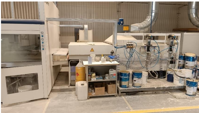
Slika 17. Prikaz postrojenja lakirnice. Dobiveno iz vlastite arhive.
