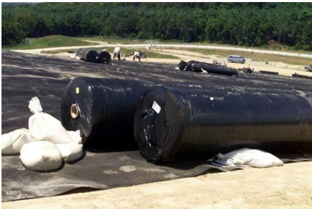
Slika 11. Geosintetički bentonitni tepisi (izvor: Građevinski fakultet, 2016)
