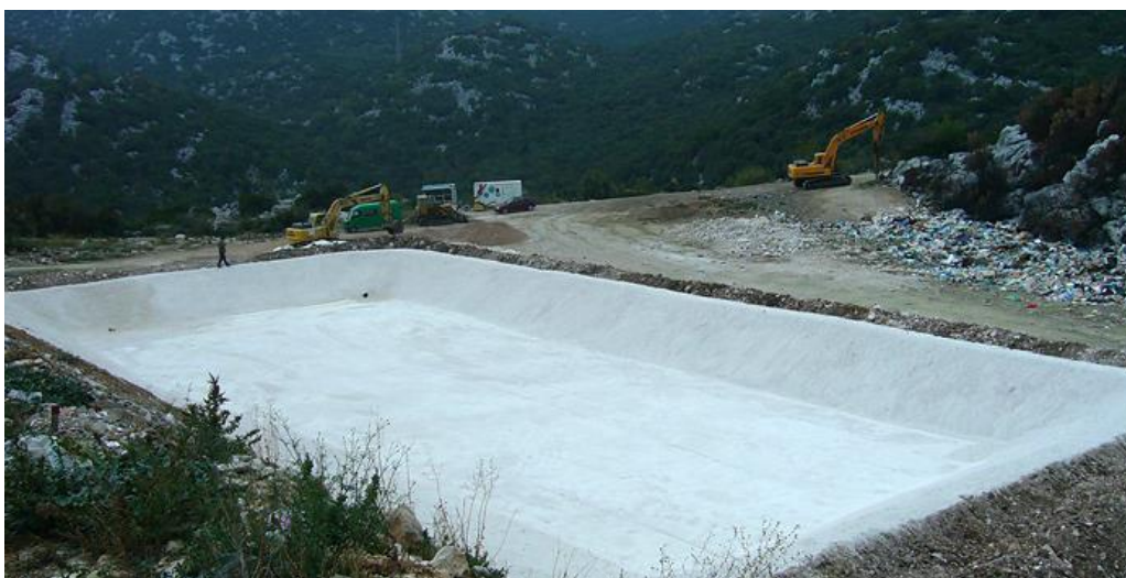
Slika 17. Primjer izgrađene kazete na odlagalištu otpada Lovornik – Grad Ploče (izvor: Sirovina, 2016)
