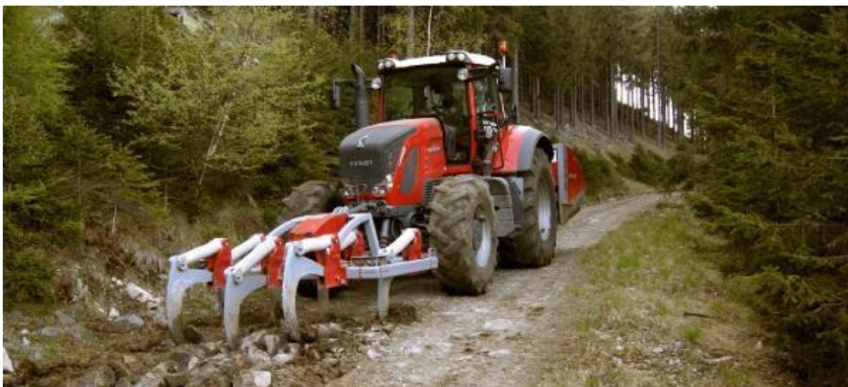
Slika 2. Metoda popravka kolnika razastiranjem materijala
